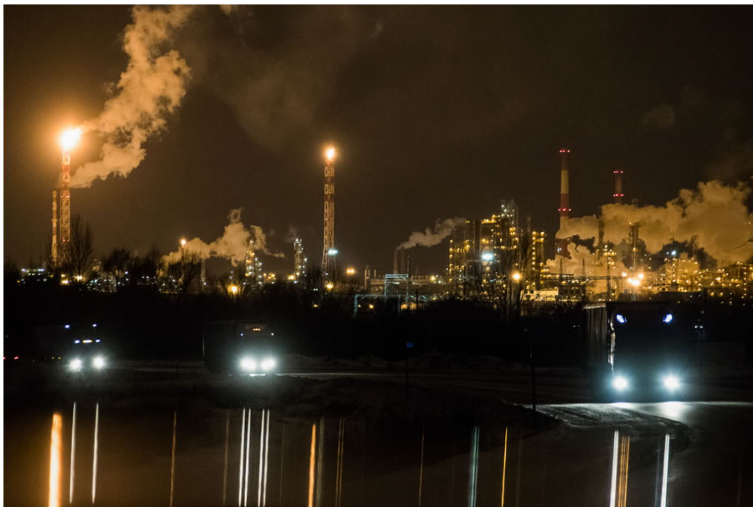
Нефтеперерабатывающий завод ООО «ЛУКОЙЛ-Нижегороднефтеоргсинтез».
