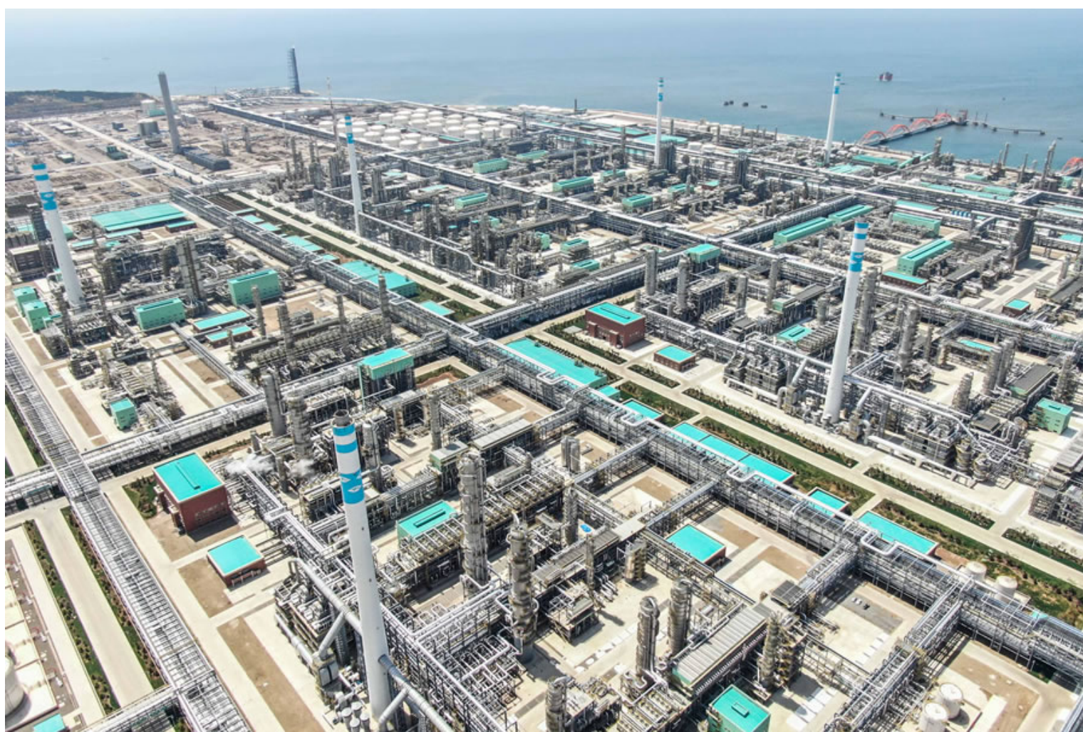
Hengli Petrochemical Refining Co., Ltd. (Dalian, northeast China).
