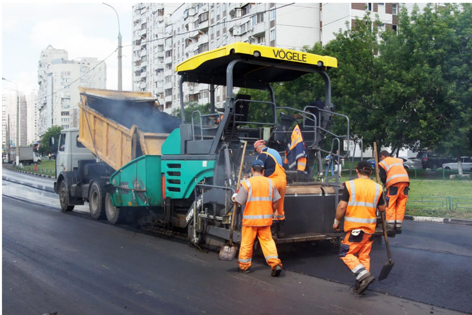
*Модификация битума ТЭП позволяет увеличить прочность дорожного покрытия, его устойчивость к перепадам температуры, воздействию воды.*
