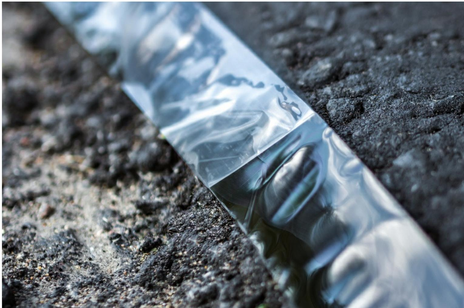
*Стыковочная лента защищает стыки между полосами асфальтобетона и места сопряжения покрытия с инженерными конструкциями – рельсами, отбойниками, бордюрами.*
