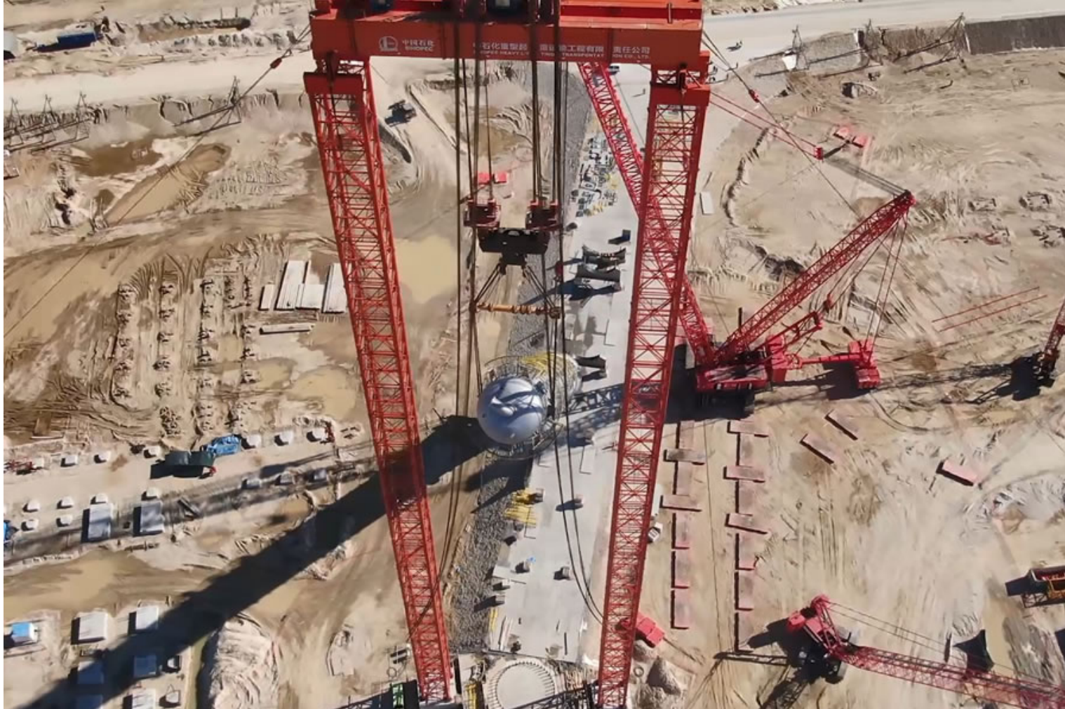
Установка самой высокой колонны АГХК.
