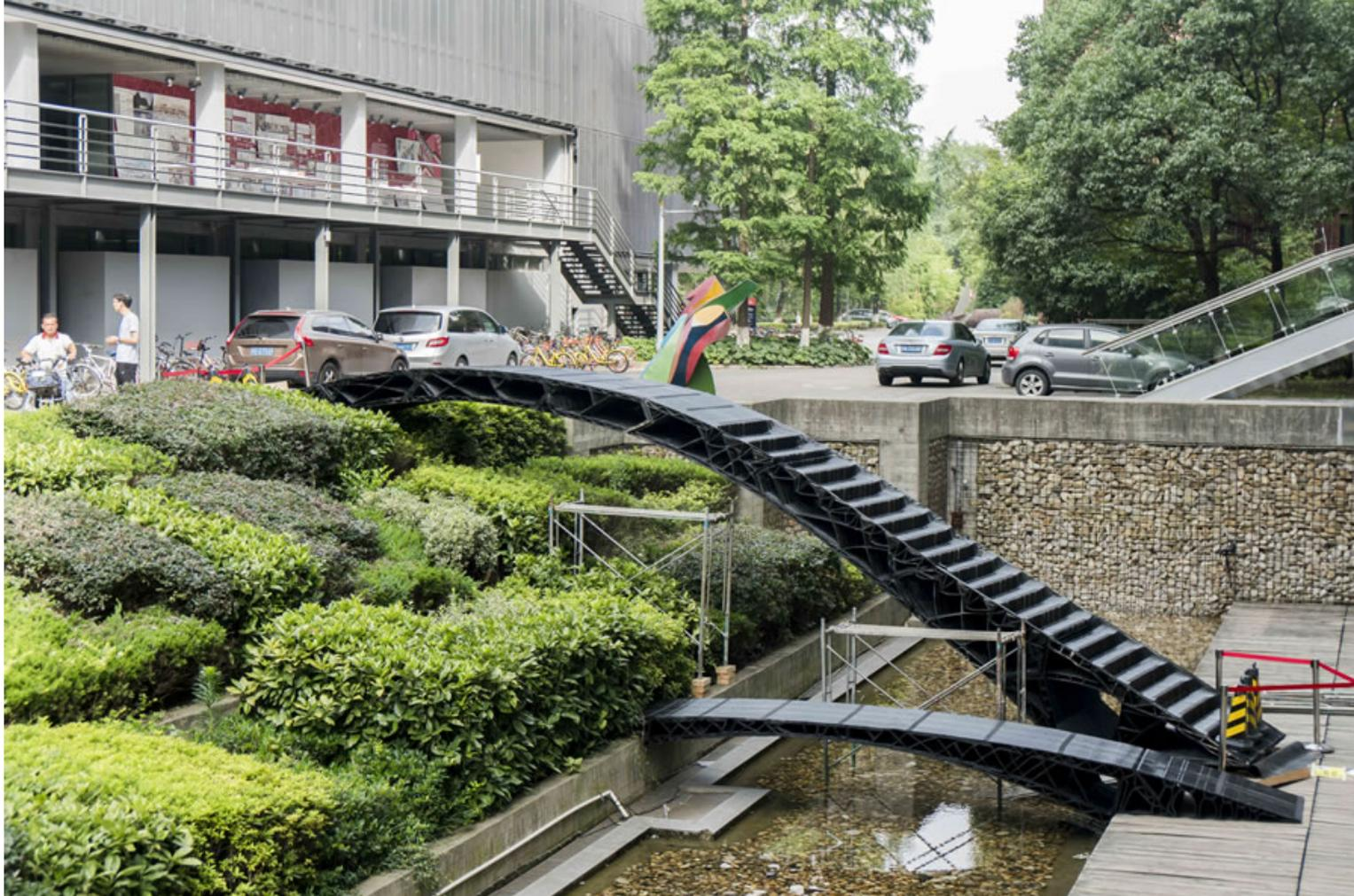
*3D-печать предлагает производителям не только вызовы, но и возможности. На фото: мост в Шанхае, напечатанный на 3D-принтере.*
